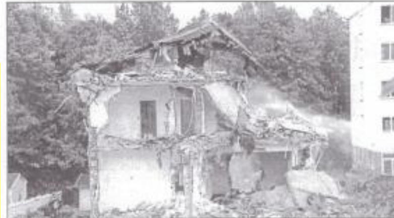
Der Abriss von drei völlig intakten, gut renovierten Mehrfamilienhäusern zugunsten eines Nachverdichtungsprojekts, nachdem sie kurz vorher zu diesem Zweck entmietet wurden. Foto: Werner Oetzel
